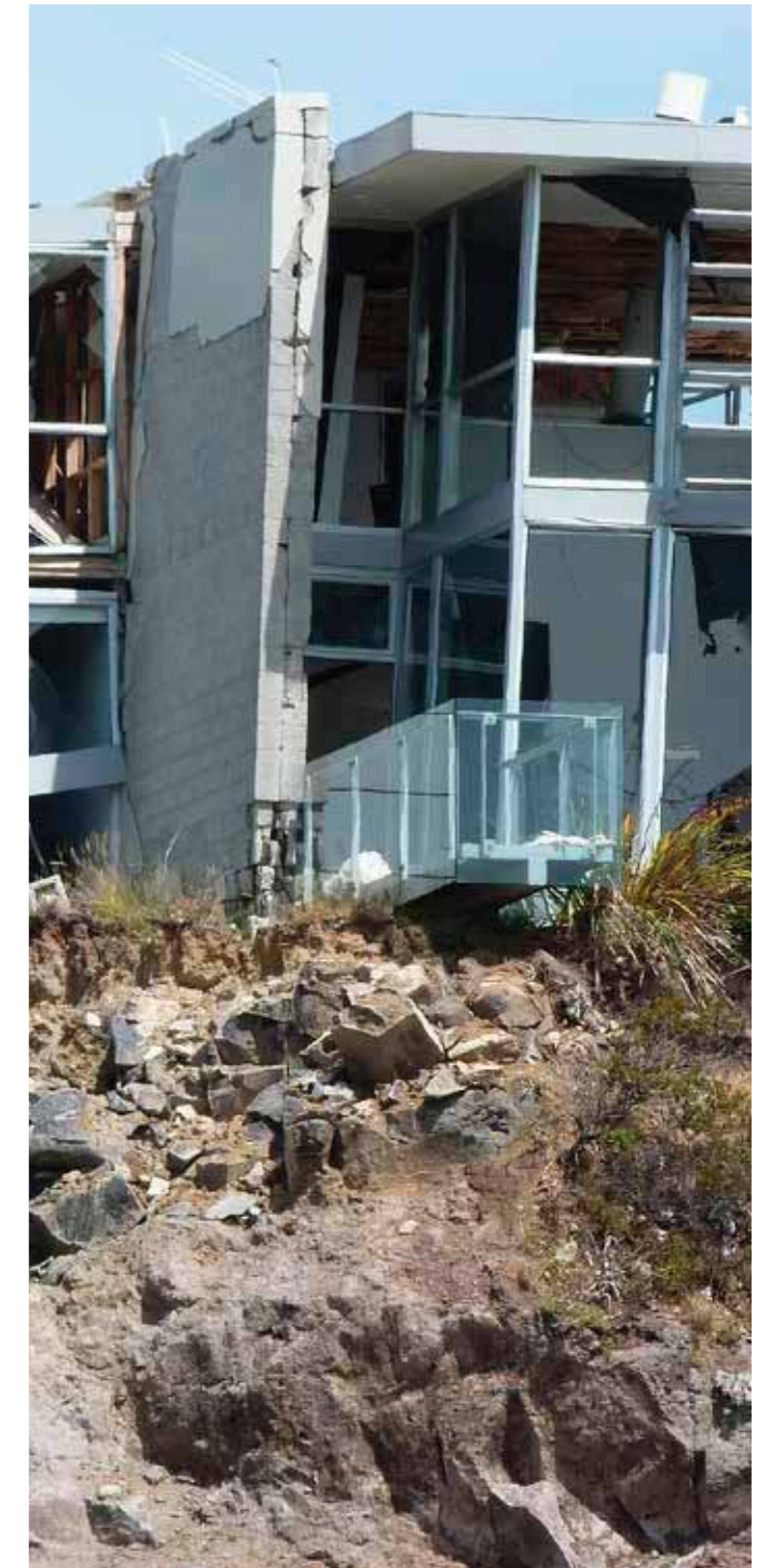
Verwoesting na de aardbeving in het centrum van Christchurch in Nieuw-Zeeland.
